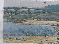
La Loire a un faible niveau lors de ces périodes de sécheresse.
