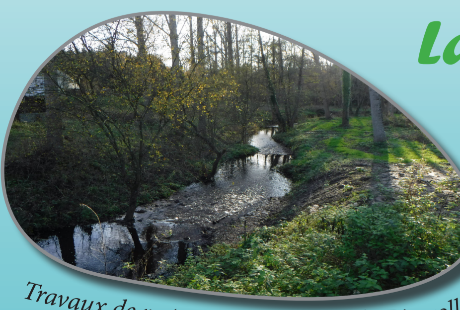
Travaux de restauration du lit de la Riverolle
