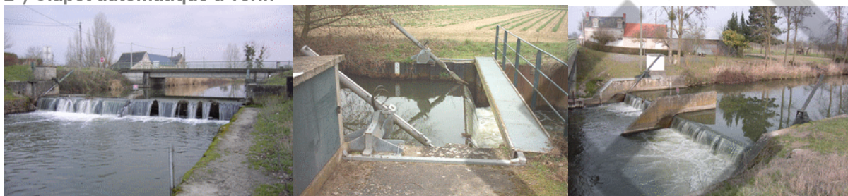
2°) Clapet automatique à vérin
