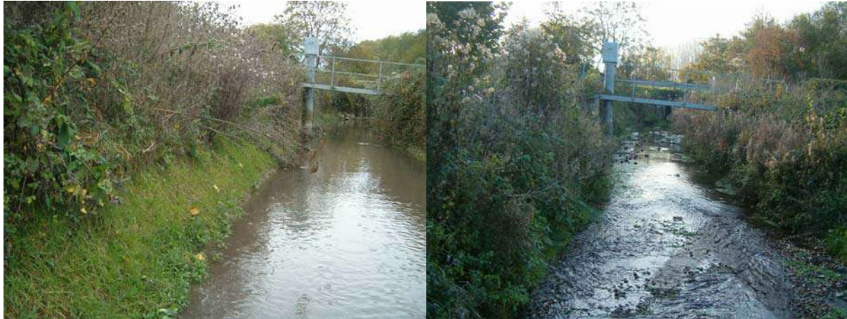
Figure 5.1 : Abaissement d'un clapet (à droite) sur le Couasnon – Pont de Singé (source SIAC)
