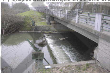
4°) Clapet automatique avec cric crémaillère
