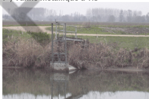
7°) Vanne métallique à vis
