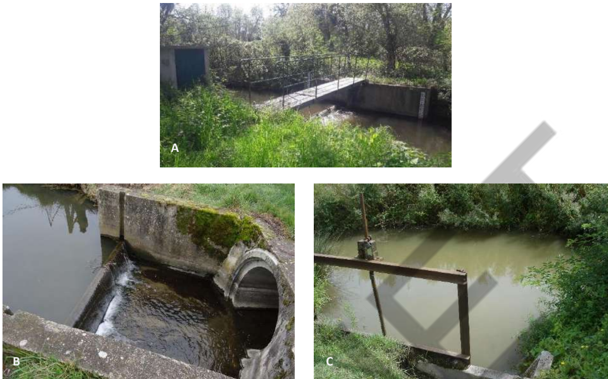
FIGURE 12 – TYPOLOGIE DES OUVRAGES HYDRAULIQUES PRESENTS DANS LE VAL D'AUTHION : (A) CLAPET DU PONT DE BOIS SUR LA BOIRE DES ROUX (X = 474706 ; Y = 6691062) ; (B) MADRIER B2 DU CANAL DE GAURE (X = 475914 ; Y = 6687689) ; (C) VANNE LATERALE DU CANAL 200, CONFLUENCE AVEC LE CANAL 301 (X = 458589.8 ; Y = 6701220.8) (CLICHES REALISES PAR COZLER LE 19/04/2018)
