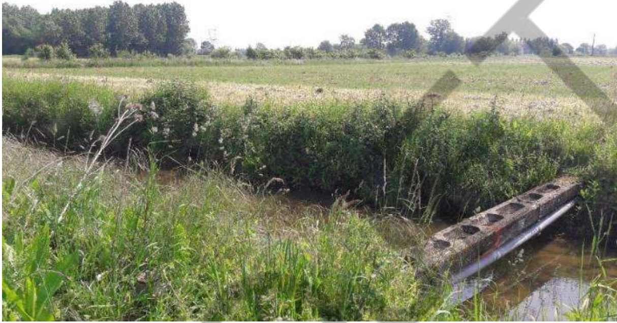
FIGURE 25 - EXEMPLE D'UN POINT DE SUIVI SEDIMENTAIRE, LE POINT N°28 SUR LE CANAL DE GAURE (X = 476290.23 ; Y = 6686877.83 ; ORIENTATION SUD-EST ; CLICHE REALISE PAR COZLER LE 16/05/2018)
