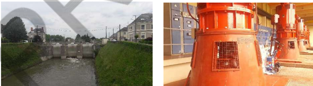
FIGURE 13 - LES VANNES DU PONT BOURGUIGNON (CLICHE DE GAUCHE ; X = 434414, Y = 6709118) ET LA STATION D'EXHAURE DES PONTS-DE-CE (CLICHE DE GAUCHE ; X = 434414 ET Y= 6709321) (CLICHEES REALISES PAR COZLER LE 14/05/2018)
