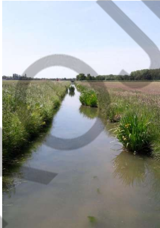
FIGURE 1 - CANAL 5007 T2 APRES TRAVAUX DE RETALUTAGE (X = -32137 ; Y = 6031940 ; ORIENTATION NORD-OUEST ; CLICHE REALISE PAR COZLER LE 18/05/2018)
