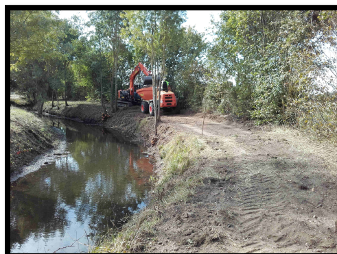
Déblais à partir des berges
