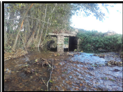
Restauration de la continuité écologique par la création d'un radier en aval du pont du « Bas de Jarrie »
