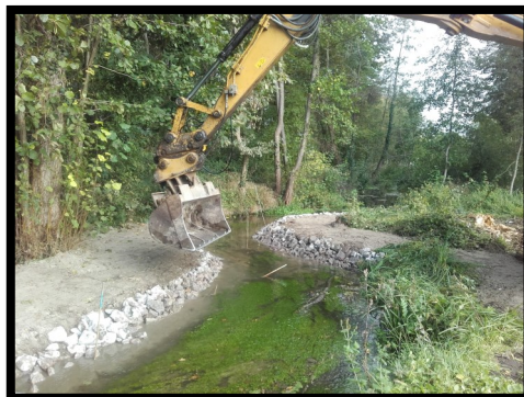
Banquettes au niveau du lieu-dit « la Riboulaie »
