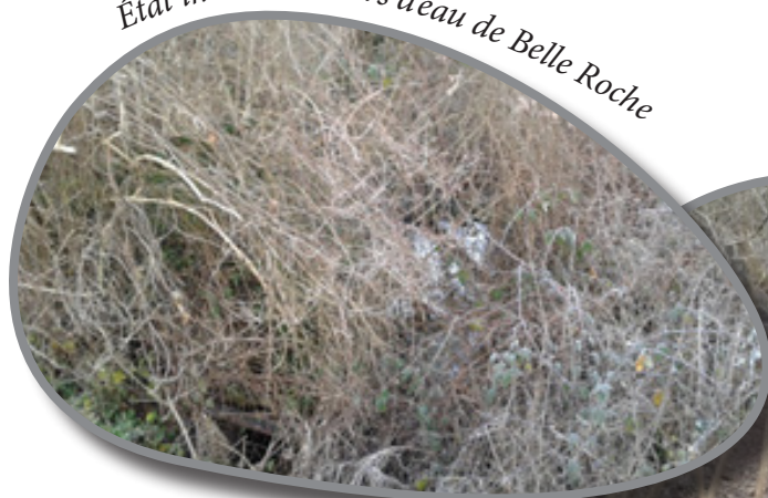
Après passage de l'entreprise d'insertion
